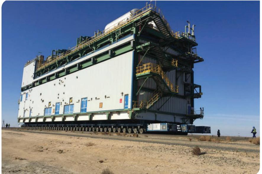
Illustration 3 - Transport d'un module type de râtelier à tuyaux
