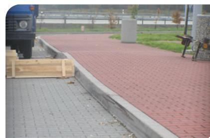
*Illustration 7 - Déformation de la chaussée à une station d'essence en raison du gonflement des déchets d'acier dans le sol de fondation (avant la réparation de 2016)*
